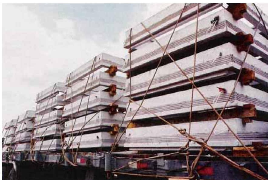
Figura 5 - Contramarcos de janelas produzidos com RCD e empregados na obra do condomínio Villagio Maia (CAPELLO-2006)
