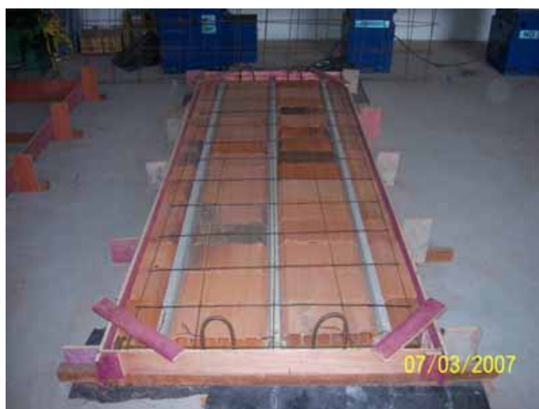
b) Laje posicionada na fôrma
