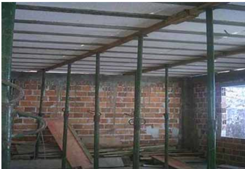
Figura 13 - Escoramento de lajes pré-moldadas
