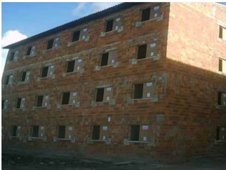
Figura 8a – Habitação popular executada com laje pré-moldada tipo trilho na cidade de Aracaju-SE
