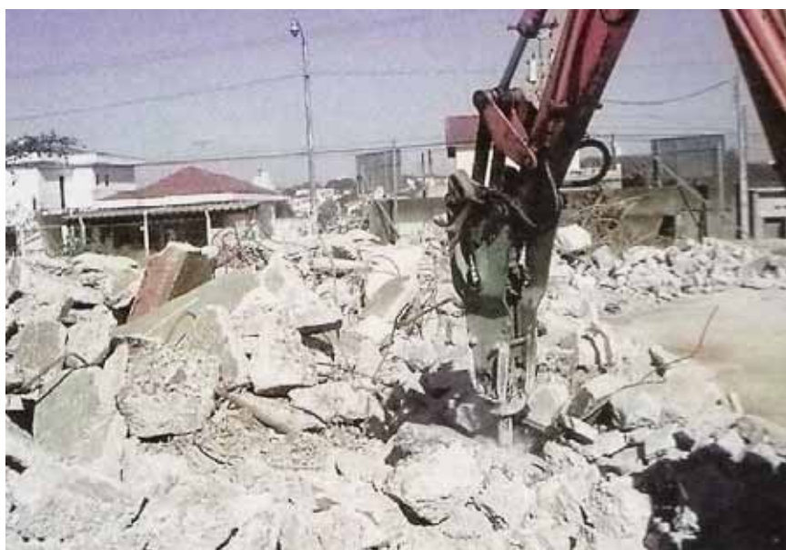
Figura 3 - Demolição do piso existente no terreno da Obra do condomínio Villagio Maia (CAPELLO-2006)
