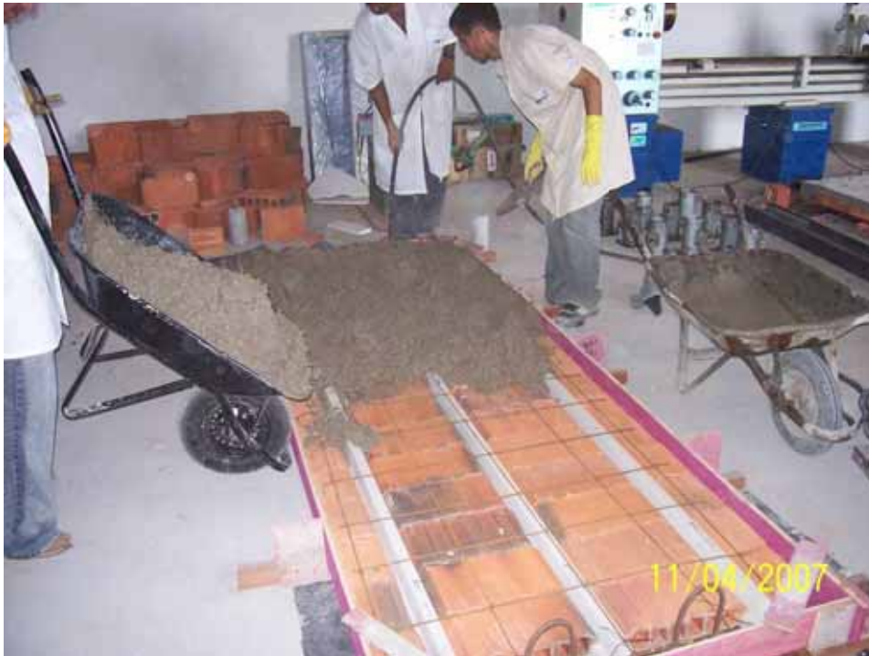
Figura 45 – Concretagem da Laje
