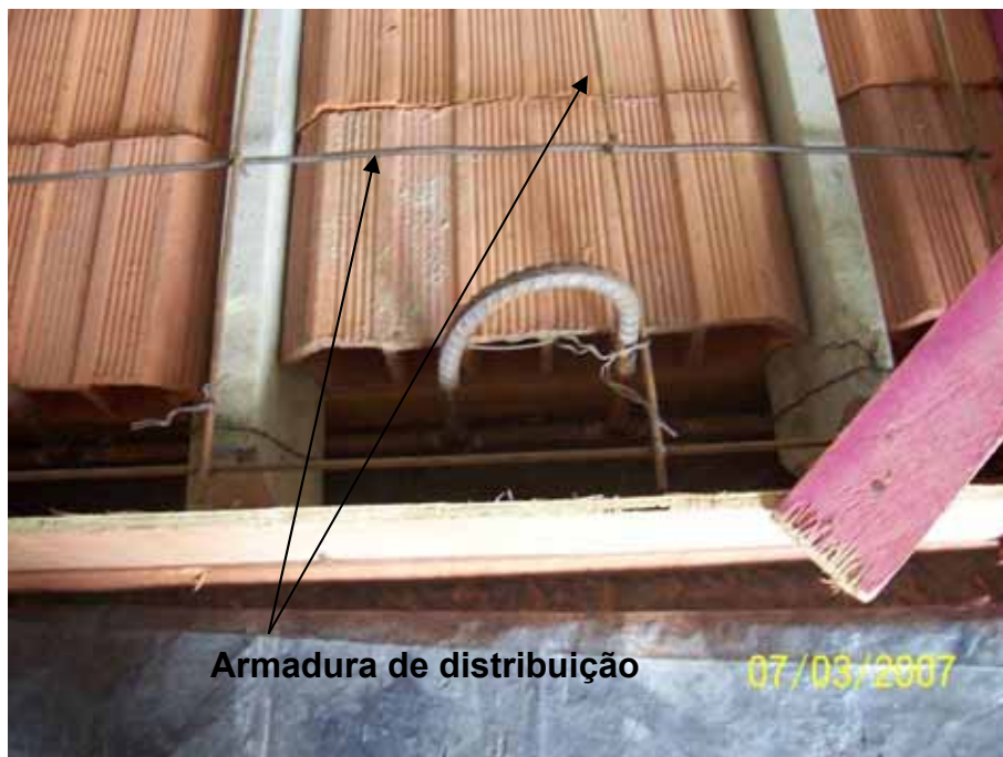
Figura 36 – Armadura de distribuição
