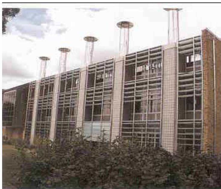
Figura 1 - O edifício do meio ambiente; 1º edifício do Reino Unido a incorporar a tecnologia de concreto usinado com a utilização de agregados reciclados (LEVY e HELENE, 2002)
