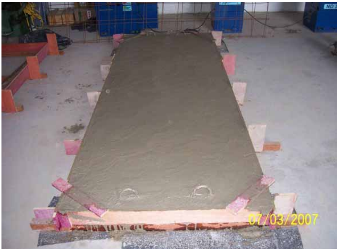
Figura 34 – Laje após a moldagem
