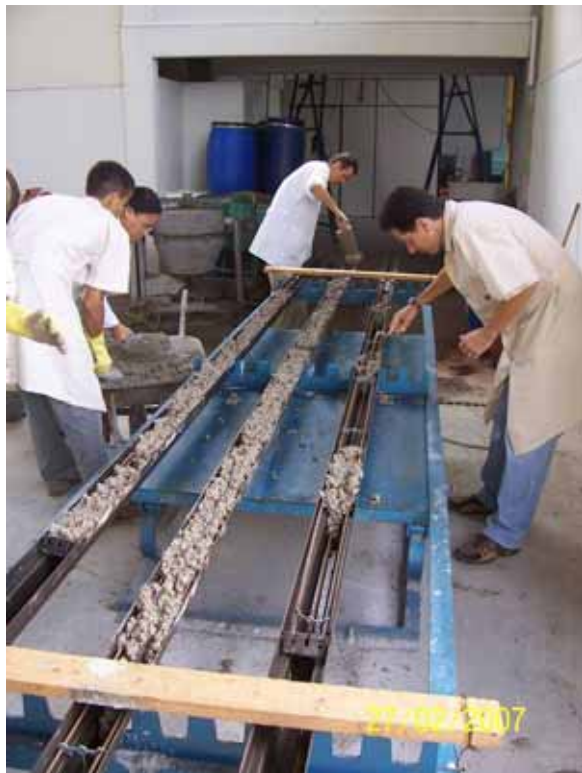
Figura 40 – Moldagem das vigotas.
