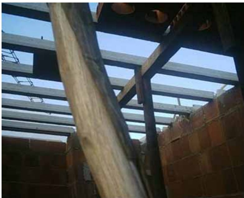
Figura 8b – Detalhe da vigota pré-moldada tipo trilho utilizada em habitação popular
