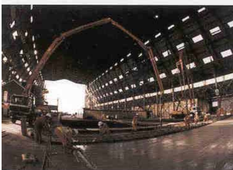
Figura 2 - Piso de alta resistência do Laboratório de Cardinton construído especialmente para analisar o efeito causado por substituição em massa de 20% de agregados reciclados de concreto e alvenaria de baixa qualidade. (LEVY e HELENE, 2002)
