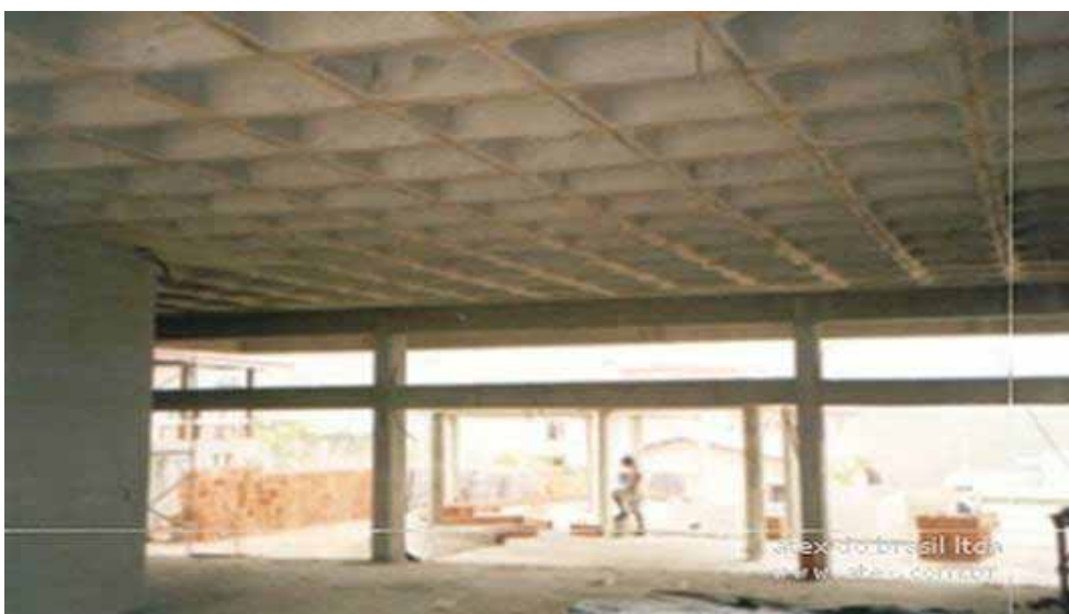
Figura 14 - Laje nervurada sem o elemento de enchimento (ATEX do Brasil)
