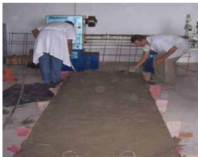
Figura 46 – Adensamento da laje com o uso de vibrador
