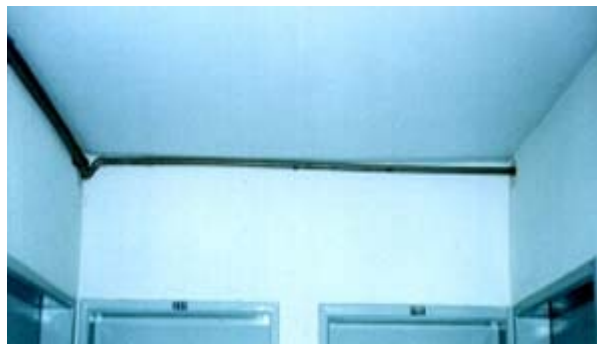
FIGURA 3 – Trajetória da tubulação nova nos pavimentos
