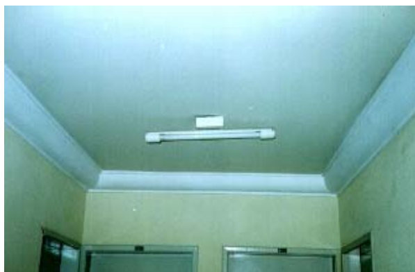
FIGURAS 4 – Detalhe do roda-teto embutindo a tubulação.
